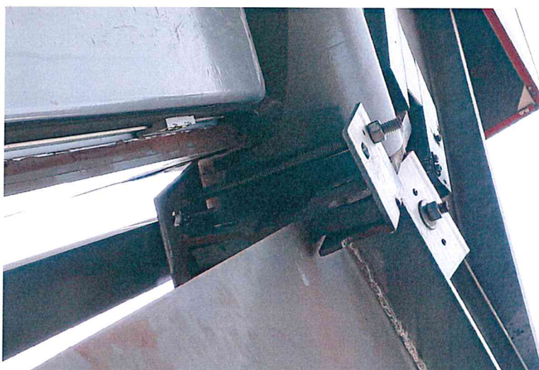
Figura 4 Estrutura de Grampeamento com viga da Lanik
