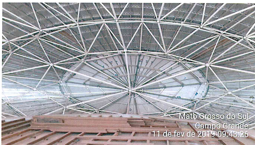
Figura 10 Execução da estrutura auxiliar para fixação do forro
