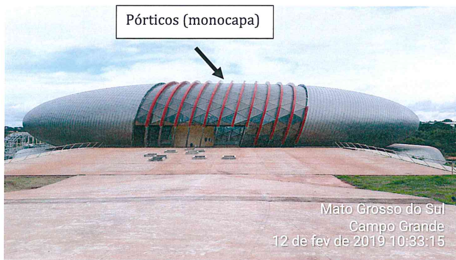
Figura 1 Revestimento dos pórticos de ACM vermelho
