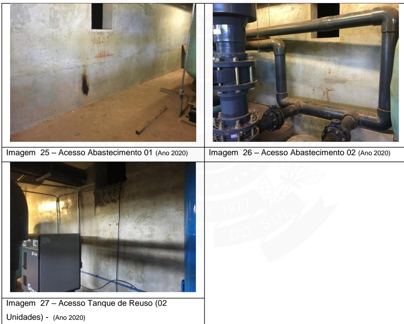
Consiste na execução de escada e/ou plataformas de acesso aos tanques de abastecimento. Deve ser desenvolvido projeto executivo para cada uma delas, por terem conflitos em seu caminho com elementos do sistema de filtragem (Tubos, Válvulas, Filtros,
