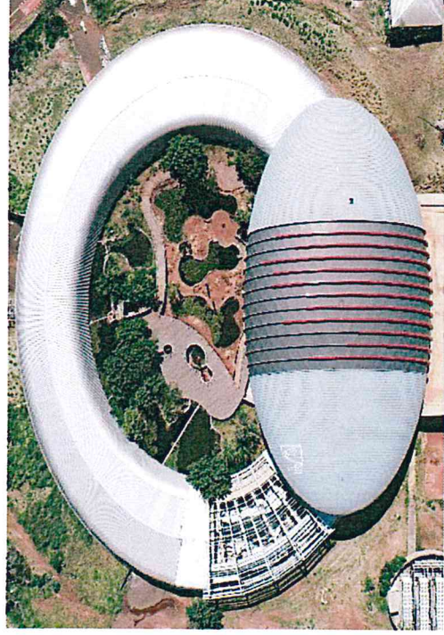
Imagem 01 – Vista Geral da Cobertura Metálica – (Ano 2019)
