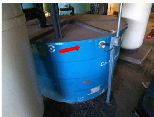
Imagem 16 - Vista externa do reservatório com sensor de nível interruptor de boia (Ano 2020)
