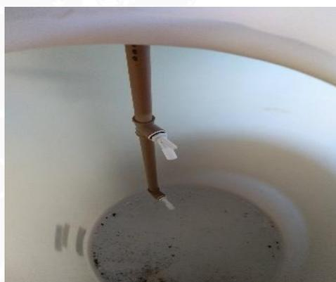
Imagem 17 - Vista interna do reservatório do sensor de nível interruptor de boia (Ano 2020)
