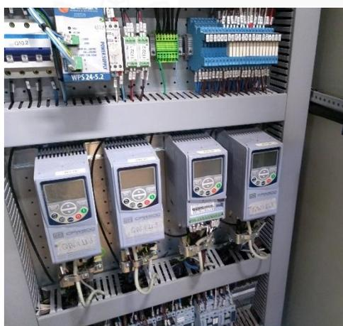
Imagem 5 - Inversores instalados
