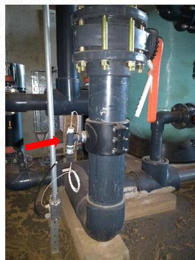
Imagem 23 - TT saída filtragem física TQ 11.3 (mesma tomada do TP) (Ano 2020)
