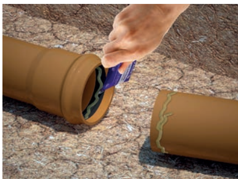
b) Aplicar a Pasta Lubrificante TIGRE no anel e na ponta do tubo. Não usar óleo ou graxa, que poderão atacar o anel de borracha.
