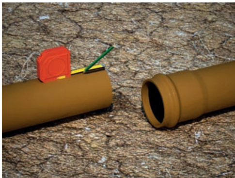
a) Marcar a profundidade da bolsa na ponta do tubo.
