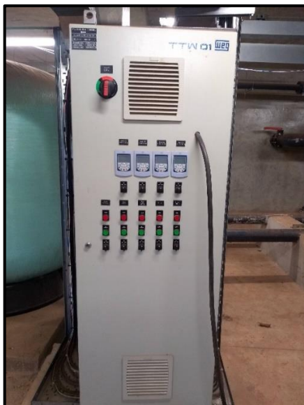
Imagem 1 - Vista Externa QDGA
